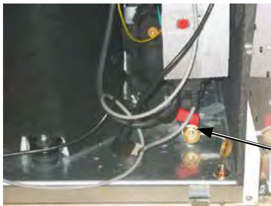
Füll- und Entleerhahn Solekreis
