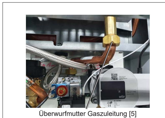
Bild: Reinigen des Gasbrenners
