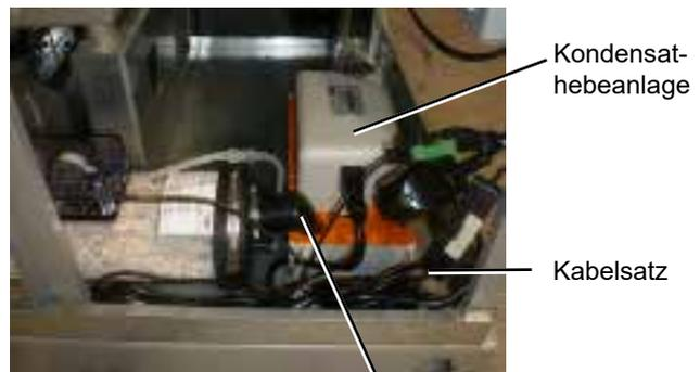
Anschluss Kondensathepumpe an Neutralisation
