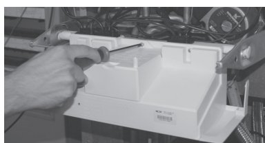
Завинтить крышку клеммной коробки
