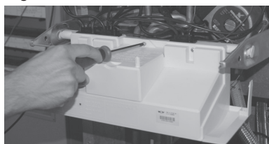
Fissare il coperchio della morsettiera
