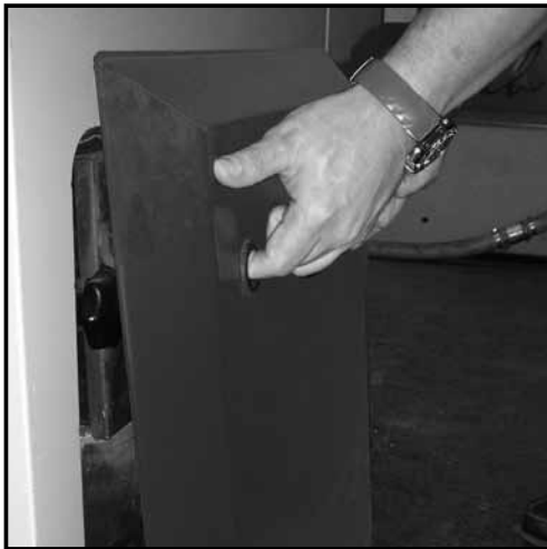
Abb. 50 Einhängen der Türverkleidung BPH25
