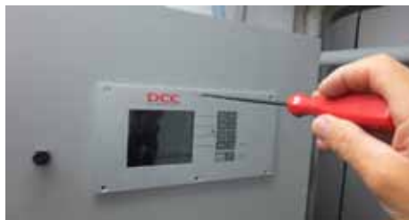
Abb. 48 Befestigung Terminal
