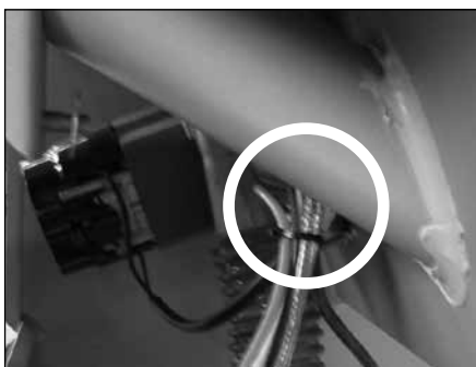
Abb. 43 Verbindung Rückluftschlauch mit der Turbine
