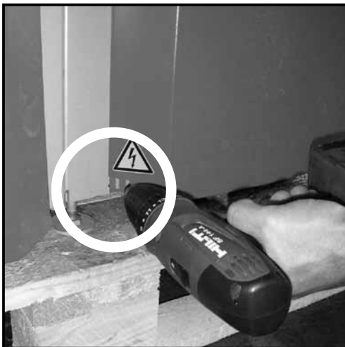
Abb. 52 Befestigung der Behälterverkleidung mittels Akku-Schrauber & mitgelieferter Schraube.
