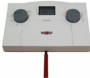
Demontage des ART vom Sockel mittels Schraubendreher
