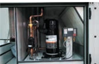
Nieder- und Hochdruck prüfen und falls erforderlich mit Kältemittel auffüllen.
