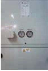
Vor dem Start des Geräts muss der integrierte mechanische Kreis entleert und mit Kältemittel gefüllt werden.
