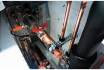
Wenn ein Beckenwasserkondensator mitgeliefert wurde, prüfen Sie, ob der Wasserdurchfluss am Fühler und die Wassertemperatur auf der HMI-Anzeige den Werten in der Dokumentation entsprechen.
