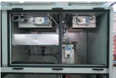
Die Kompaktfilter können nicht gereinigt werden. Sie müssen bei Verschmutzung und spätestens alle 12 Monate ersetzt werden.
