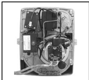
Bild: Einbaulage Brenner
