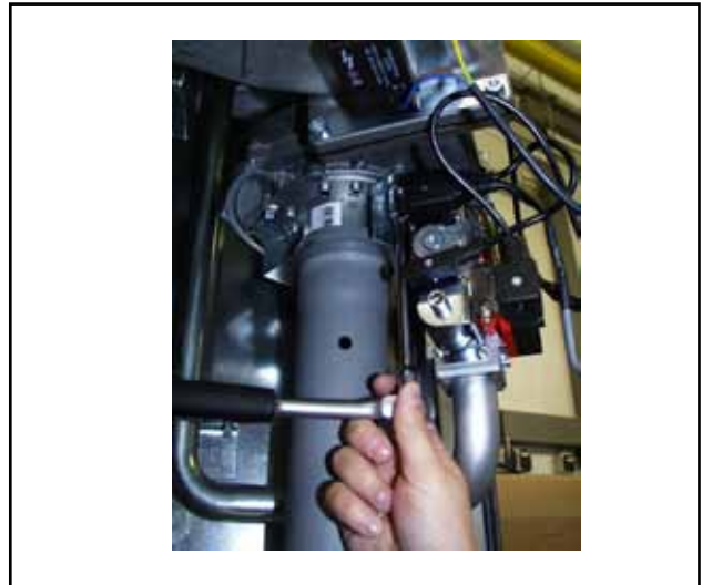
Bild: Schrauben zwischen Gebläse und Mischkammer lösen
