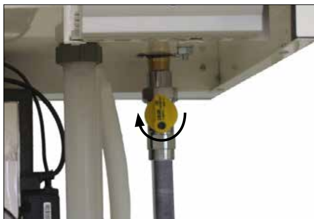
Illustration : Raccord de gaz Danger d'intoxication et d'explosion dû aux émanations de gaz
