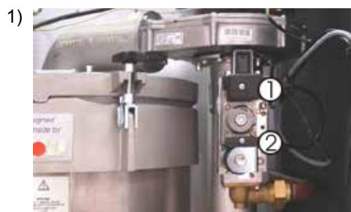
Træk stikket ① ud ② (løsn først krydskærvskrue)
