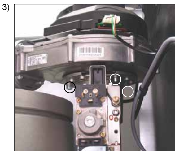
Mischkammer vom Ventilator (3 Stck. Innen-Sechskantschrauben 5mm) abschrauben evtl. Luftansaugrohr abziehen
