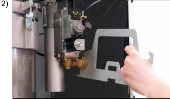
Gaz bağlantısının cıvatalarını gazlı kombi valfinden çözün
