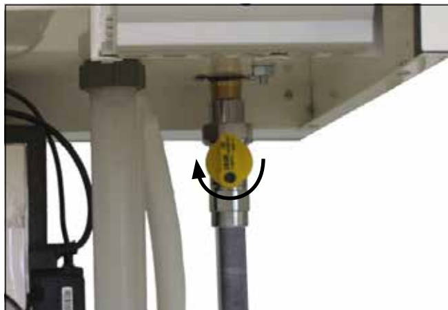
Billede: Gastilslutning Fare for forgiftning og eksplosion pga. udstrømmende gas
