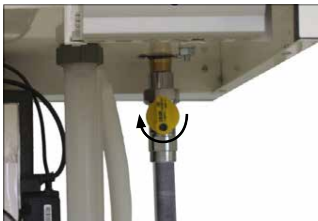
Εικόνα: Σύνδεση αερίου Κίνδυνος δηλητηρίασης και έκρηξης λόγω διαρροής αερίου
