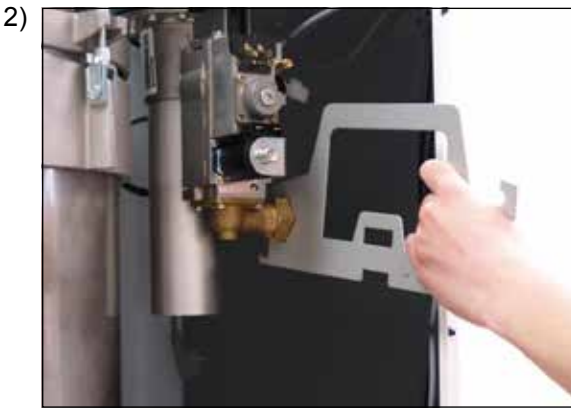
Gaz bağlantısının cıvatalarını gazlı kombi valfinden çözün
