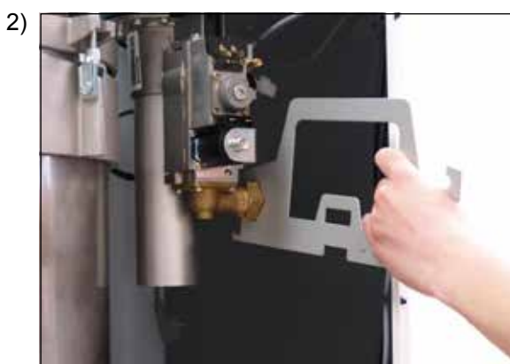
Verschraubung Gasanschluss am Gaskombiventil lösen
