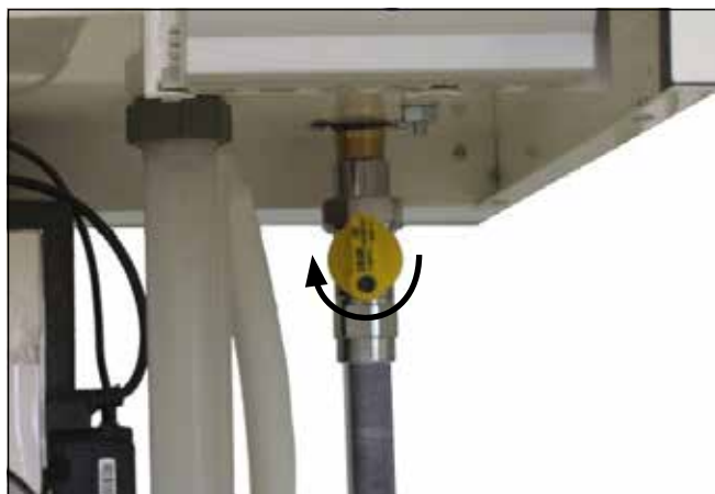
Figura: Conexión de gas Peligro por intoxicación y explosión por escape de gas
