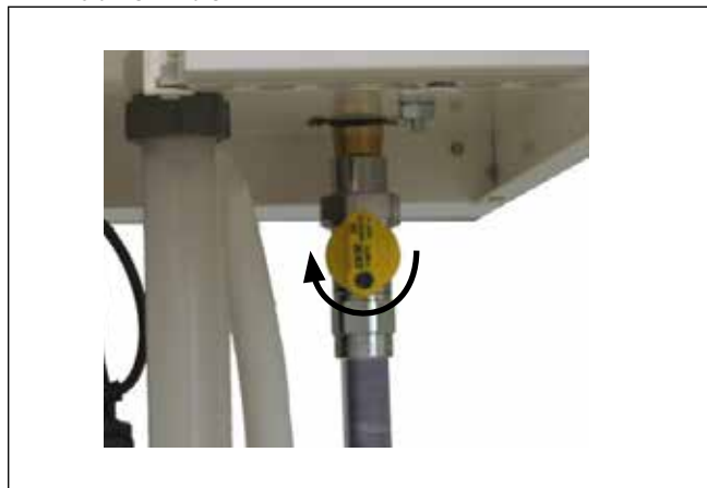
Ilustracja: Przyłącze gazowe Istnieje niebezpieczeństwo zatrucia lub wybuchu na skutek ulatniającego się gazu
