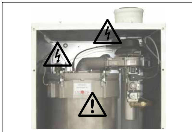
Рис.: Трансформатор поджига, электрод поджига, теплообменник Опасность поражения электрическим током, Опасность ожога из-за нагретых деталей
