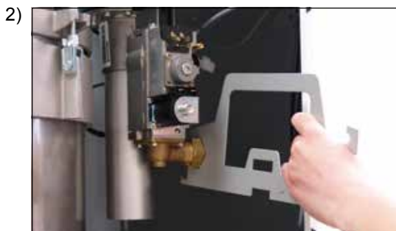
Poluzować złącze śrubowe przyłącza gazowego na zaworze gazowym
