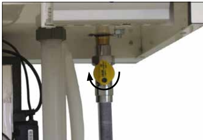
Figura: Attacco gas Pericolo di intossicazione e di esplosione per fuoriuscita di gas
