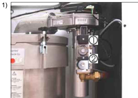
Stecker ①② abziehen (vorher Kreuzschlitzschrauben lösen)
