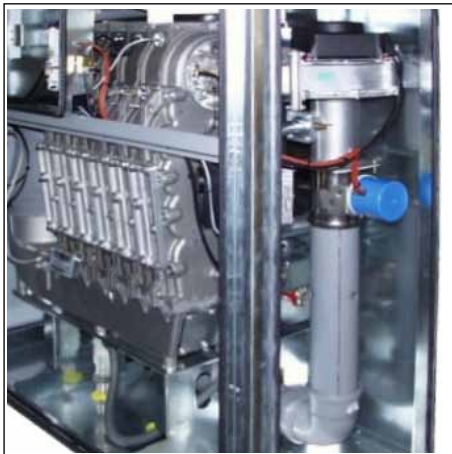
Innenansicht mit Zuluftklappe nach Einbau
