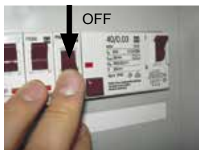
Abb. 3.1 Anlage spannungslos schalten
