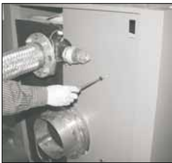
Verschraubung der hinteren Verkleidungsbleche an das Gusshinterglied
