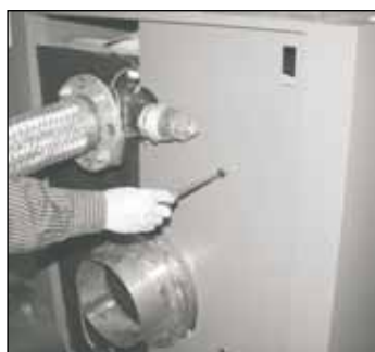
Verschraubung der hinteren Verkleidungsbleche an das Gusshinterglied
