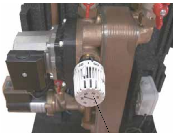
tepelný regulátor s konstantně nastavenou teplotou
