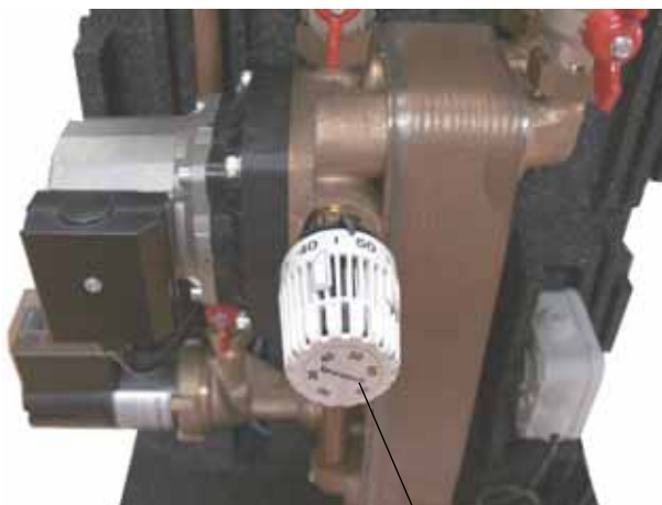
termostatický regulátor s konštantne nastavenou teplotou
