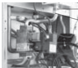
Eingangsstutzen Brenner
