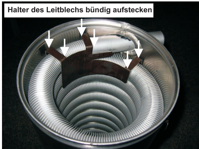
Bild 1: Einbau Leitblech (Brennkammerdeckel abnehmen)
