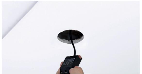
2 - Quick-Anschlussbox wird über den 68-mm-Ausschnitt im Hohlraum platziert
