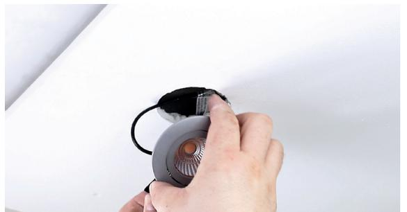
4 - Verbinden des Netzgeräts mit dem Spot mittels Steckverbinder
