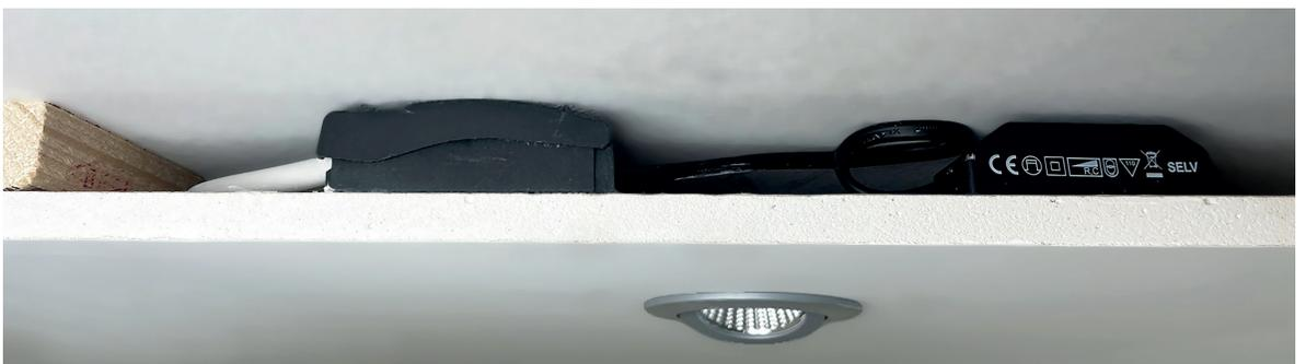
6 - Das Ergebnis: eine kompakte Installation mit einem schwenkbaren Spot, einem dimmbaren Netzgerät sowie der Möglichkeit zur Durchgangsverdrahtung im Deckenhohlraum – ideal im Sanierungsbereich.
