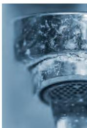
Kalkablagerungen an elektrischen Geräten wie Wasserkocher, Waschmaschinen, Durchlauferhitzer etc. sind nicht nur unschön, sie erhöhen sogar deren Energieverbrauch. Kalkablagerungen in den Leitungen können sogar bis zum sogenannten Rohrinfarkt führen.
