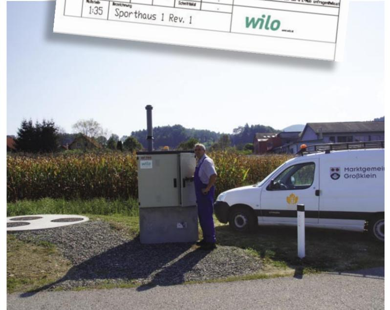
Die Regelung der Pumpstation inkl. GSM-Modul für eine SMS Benachrichtigung ist in einem modernen Wilo-Freiluftschaltschrank integriert.
