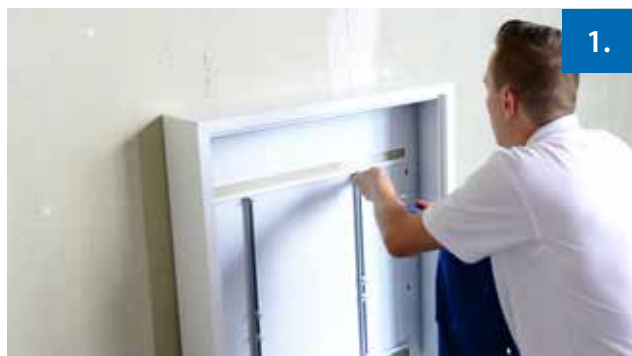
Schritt 1: Verteilerschrank setzen
