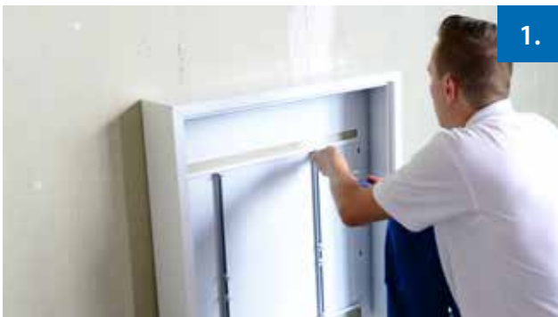
Schritt 1: Verteilerschrank setzen
