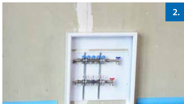
Schritt 2: Verteiler einbauen
