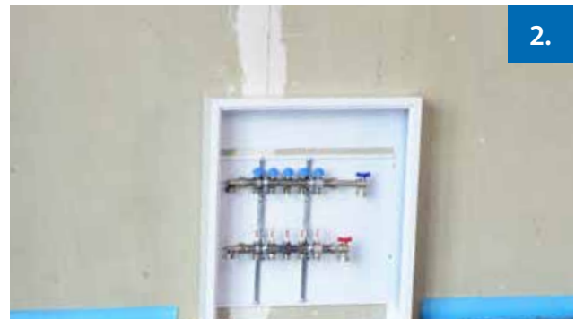
Schritt 2: Verteiler einbauen
