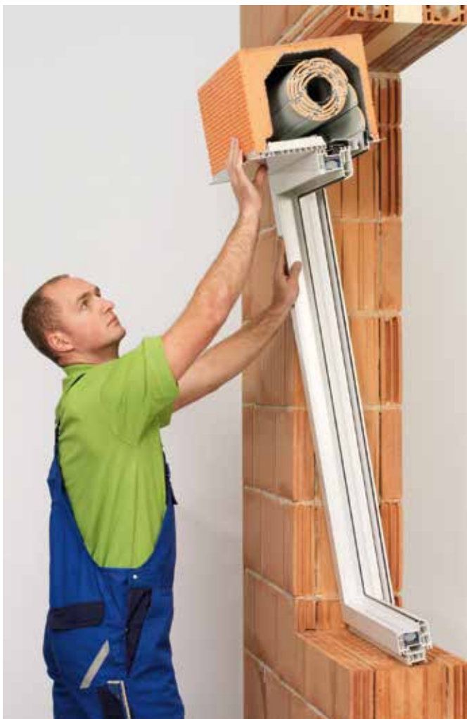
PUR-Hartschaumelement PURO (links) für Putz- und PURO.K (rechts) für Klinkerfassaden (innenliegende Revision)
