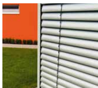
Beispiel mit geböckelter Raffstorelamelle und seitlichen Führungsschienen
