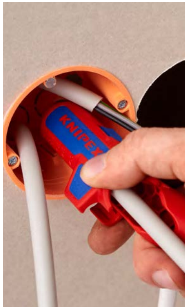
Abmanteln eines NYM-Kabels
