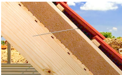
Befestigung von Aufdachdämmungen
