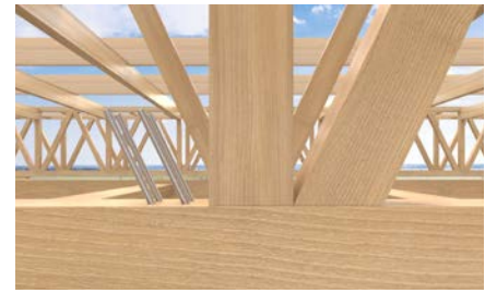
Holz-Holz-Verbindung
