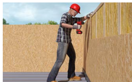
Befestigung von OSB-Platten auf Holzständern im Holzrahmenbau
