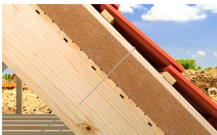
Nicht druckfeste Dämmstoffe in der Aufdachdämmung
