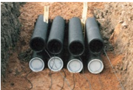
Kabuflex S – distanční rozpěrky umožňují bezpečnou a rychlou pokládku
