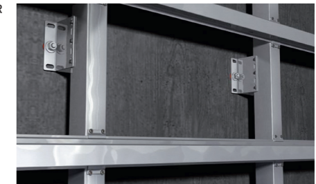
Fassadenunterkonstruktion
