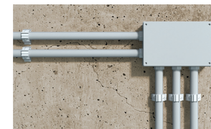
Befestigung von Kabelschellen/Verteilerdosen
