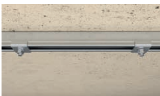
Direktmontierte Montageschiene: HK, FUS Montageschiene
