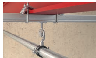
Montageschiene an Stahlträger: TKR, FUS Montageschiene
