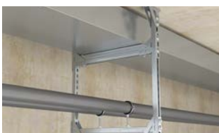
Rahmenkonstruktion zur Deckenabhängung mit zwei Ebenen: PUWF
