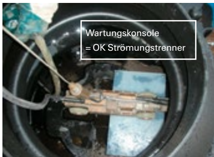
Kontrolle des Spülerfolges mit Dreh-Schwenkkopf-kamera, Kamera auf der Wartungskonsole im Startschacht einer SediPipe L - Anlage
