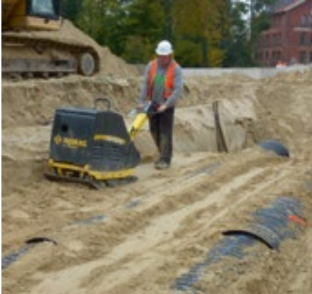
Verdichten der Seitenverfüllung
